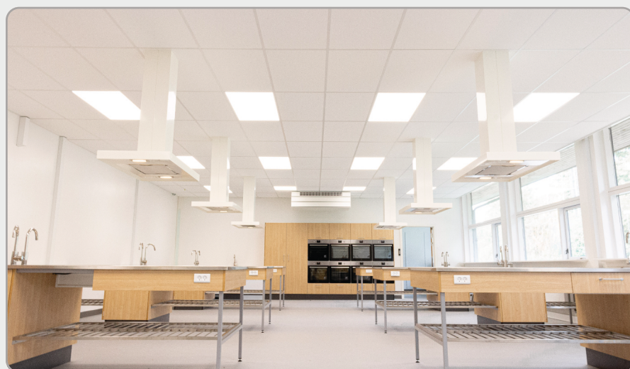
Hvidlakeret model VKIN-A: Frithængende med tilslutning over nedhængt loft.
